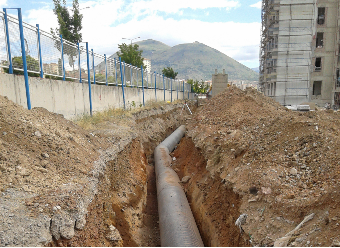
İÇMESUYU ŞEBEKE DÖŞEME ÇALIŞMALARI
