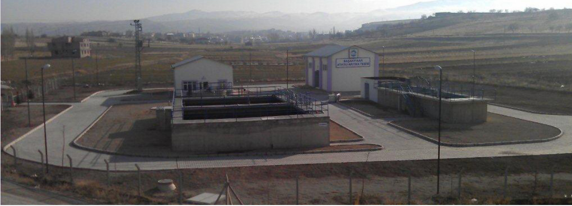
Başakpınar Atıksu Arıtma Tesisinden Bir Görünüm
