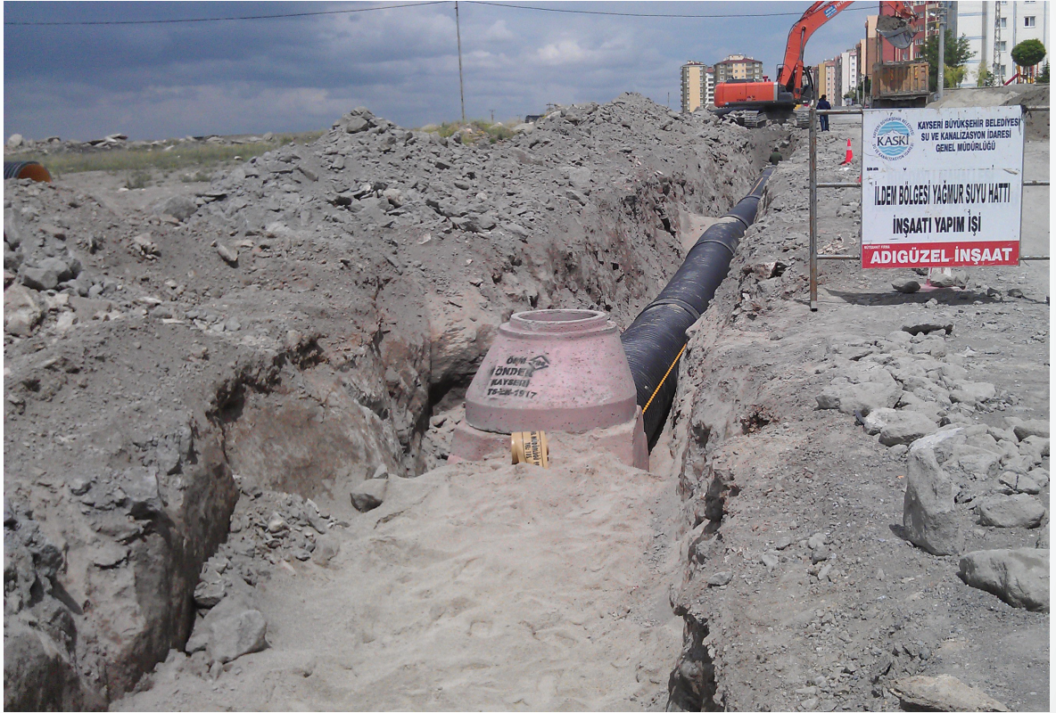
İldem Bölgesi Yağmursuyu Hattı İnşaatı İşinden Bir Görünüm
