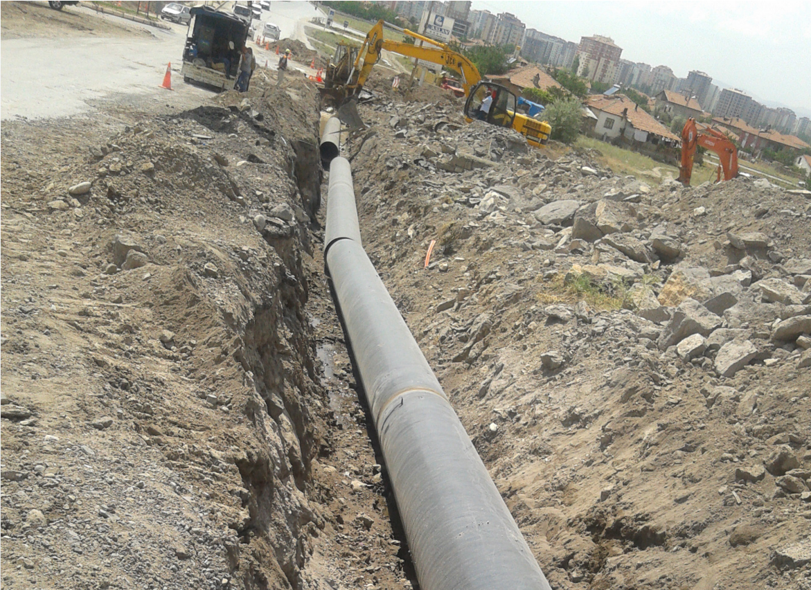
İÇMESUYU ŞEBEKE DÖŞEME ÇALIŞMALARI
