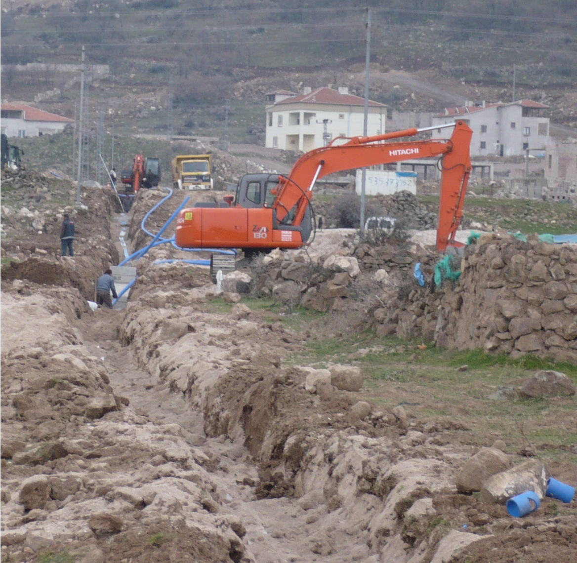
İncesu Karpuzsekisi İçmesuyu ve Kanalizasyon Şebeke Hattı İnşaatı İşinden Bir Görünüm
