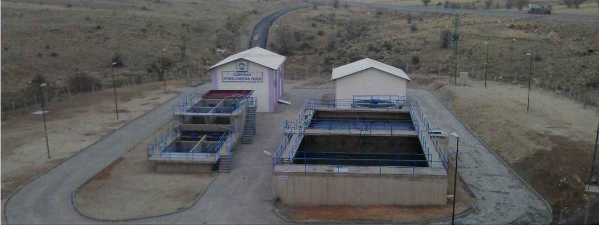
Gürpınar Atıksu Arıtma Tesisinden Bir Görünüm
