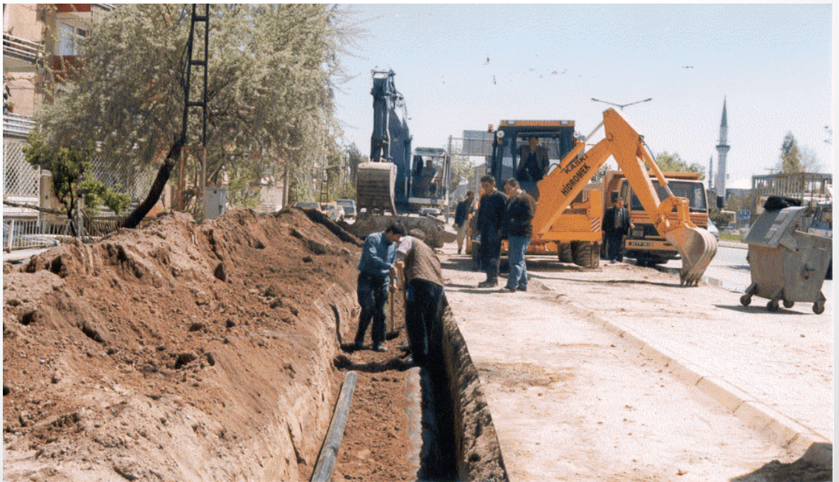
İÇMESUYU BORUSU DÖŞEME ÇALIŞMALARI
