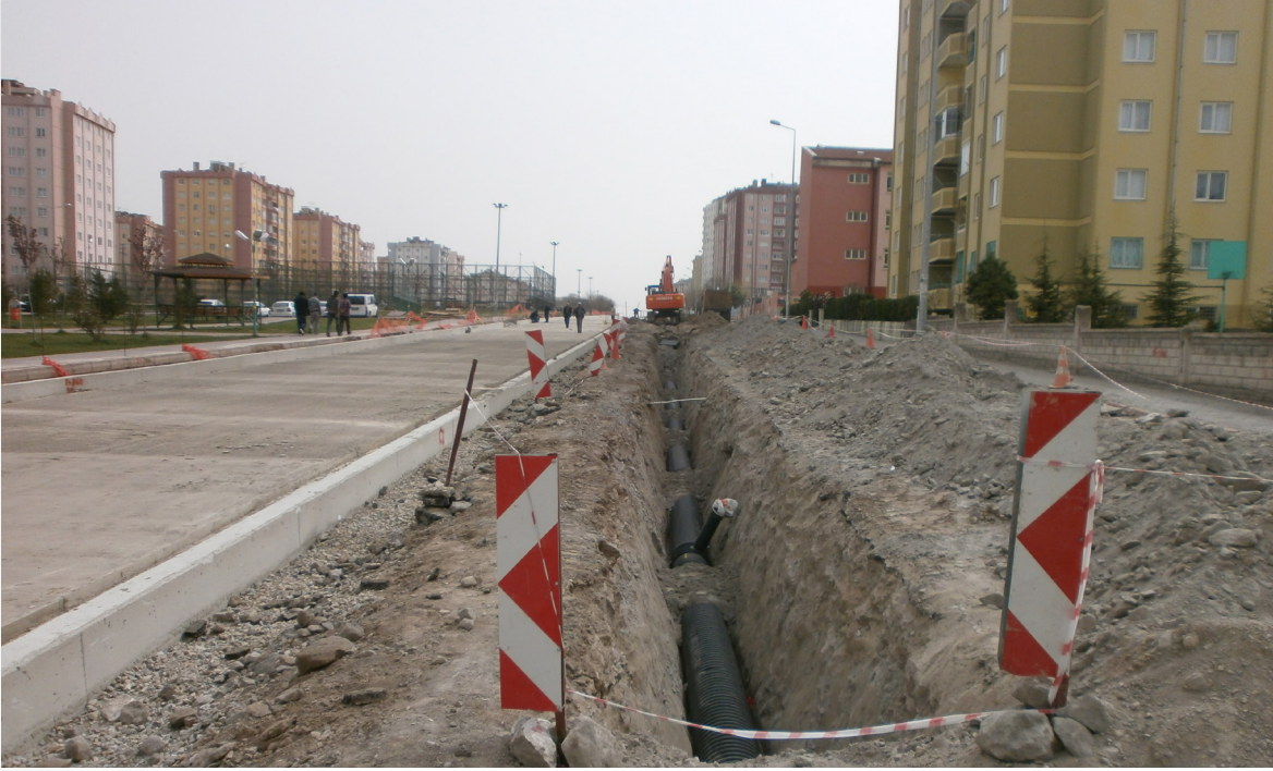
İldem Bölgesi Yağmursuyu Hattı İnşaatı İşinden Bir Görünüm
