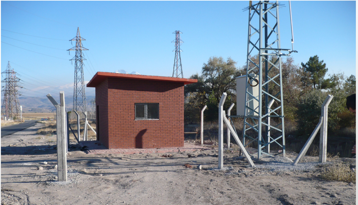
Kuyu Binaları Yapımından Bir Görünüm
