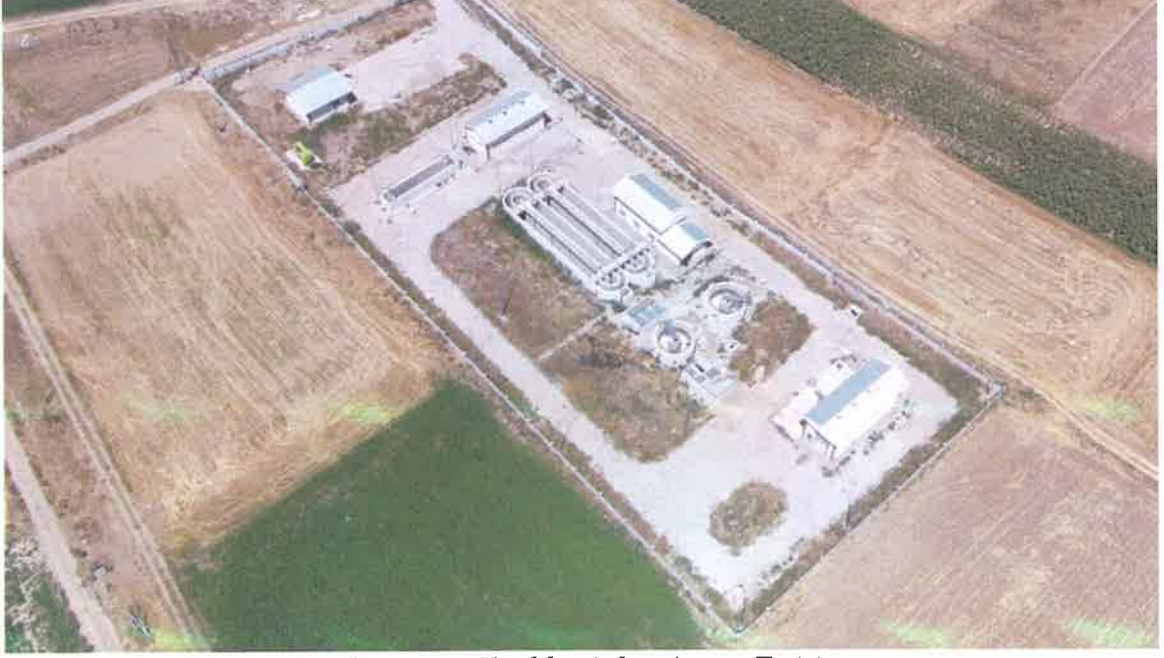
Kocasinan Yemliha Atıksu Arıtma Tesis
