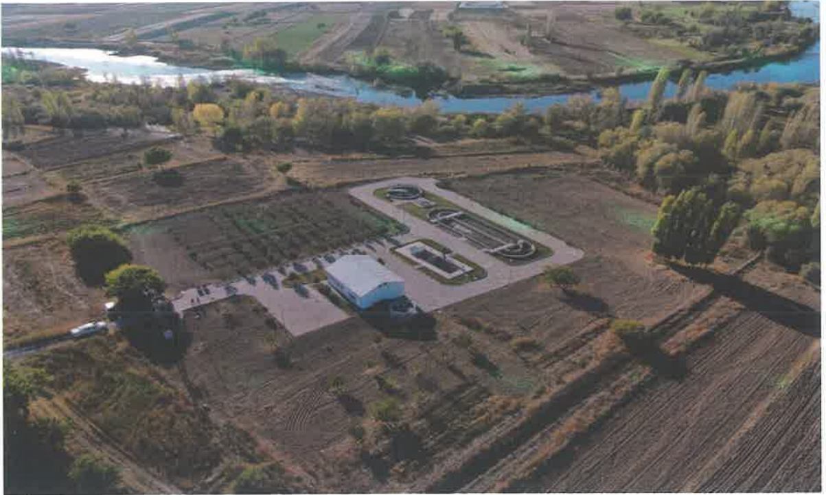
Kocasinan Ebiç Atıksu Arıtma Tesis
