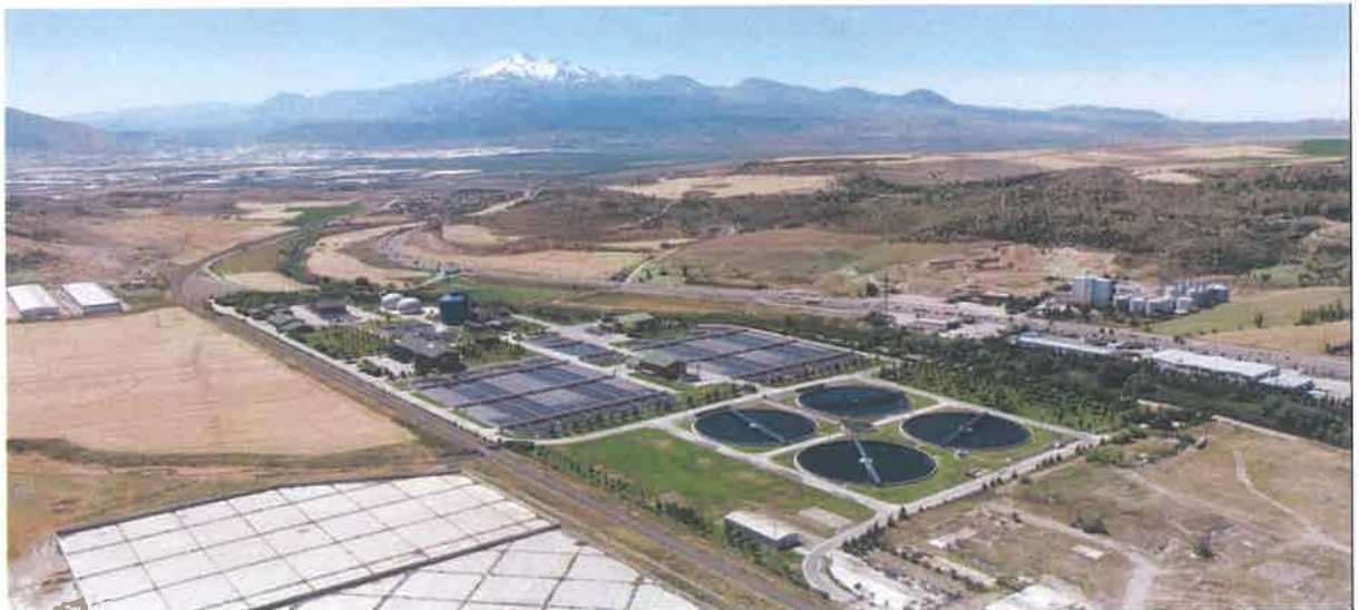
Kayseri İleri Biyolojik Atıksu Arıtma Tesisi
