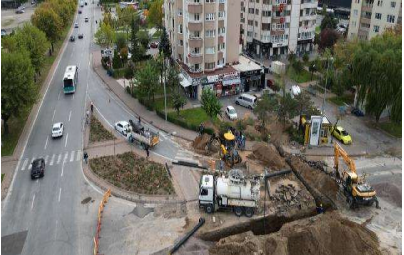
Şekil-5: Alt Bölge Odası Bağlantısı ve Montajı
