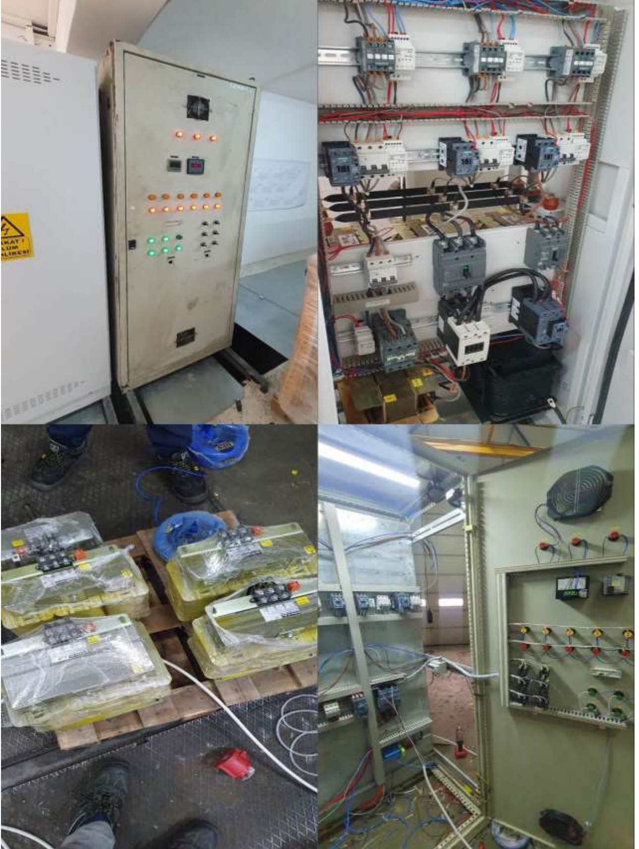
Kibaat GES Şönt Reaktör Panosu Yapımı
