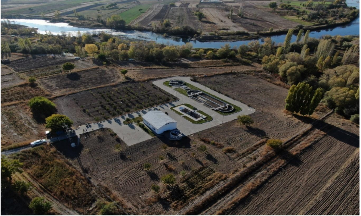
Kocasinan Ebiç Atıksu Arıtma Tesis
