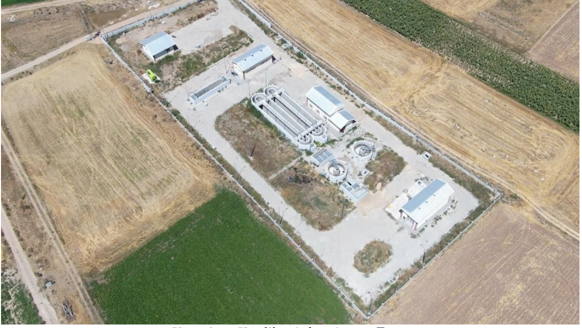
Kocasinan Yemliha Atıksu Arıtma Tesis
