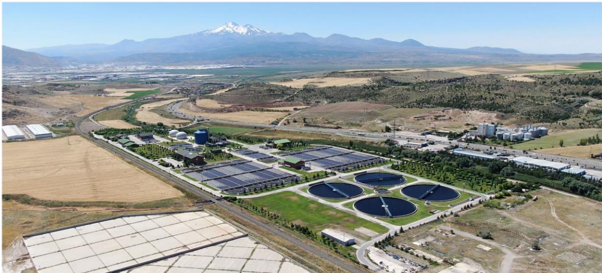
Kayseri İleri Biyolojik Atıksu Arıtma Tesisi
