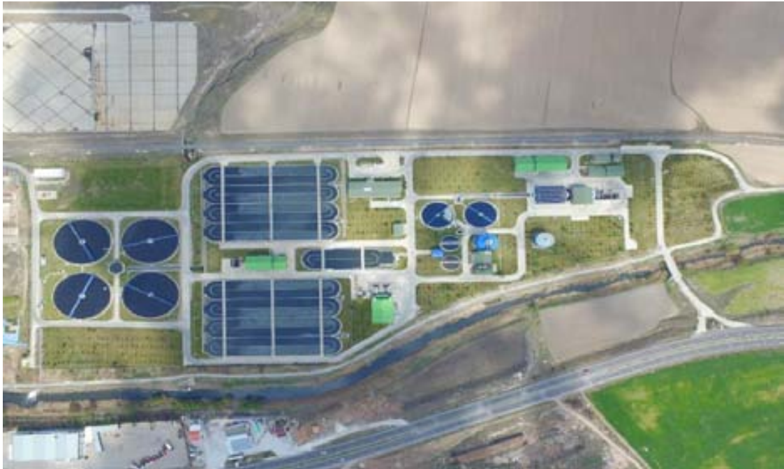
Kayseri İleri Biyolojik Atıksu Arıtma Tesisi
